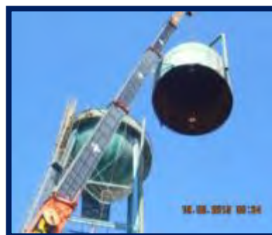
Desmontaje del Tanque elevado
