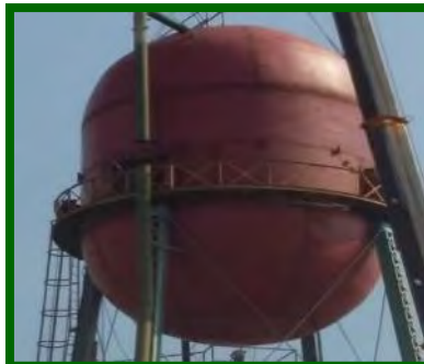
Fabricación y montaje del nuevo Tanque elevado
