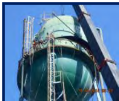
Desmontaje del Tanque elevado
