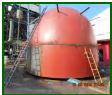
Fabricación y montaje del nuevo Tanque elevado
